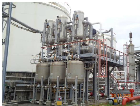
ภาพที่ 2.2-8 Vent Condensing Unit
