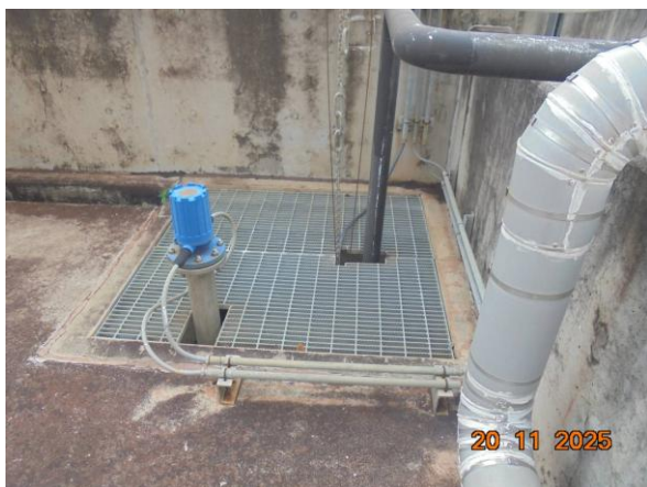
ภาพที่ 2.2-13 ป่อักเก็บน้ำปนเปื้อนสารเคมีภายใน Pit
