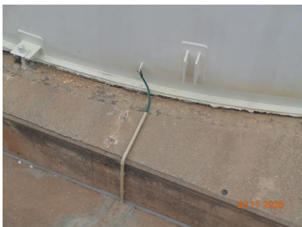
ภาพที่ 2.2-46 ระบบป้องกันอันตรายจากฟ้าผ่า รอบถังเก็บผลิตภัณฑ์
