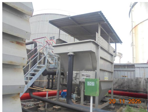
ภาพที่ 2.2-14 Oil-Water Separator
