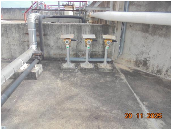
ภาพที่ 2.2-1 Gas Detector
