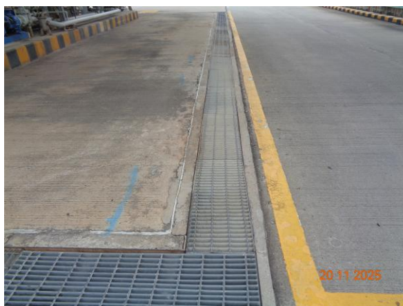
ภาพที่ 2.2-15 รางรองรับสารเคมีเมื่อเกิดการรั่วไหล
