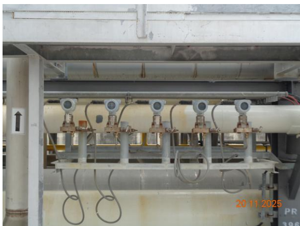
ภาพที่ 2.2-7 Pressure Transmitter
